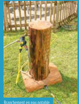
Branchement en eau potable.
