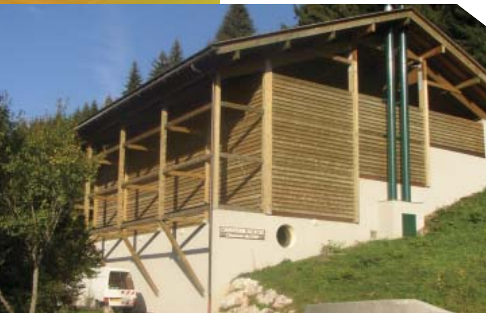
Vue de la chaufferie automatique au bois déchiqueté.
