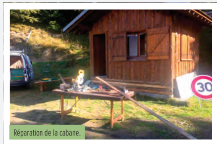
Réparation de la cabane.
