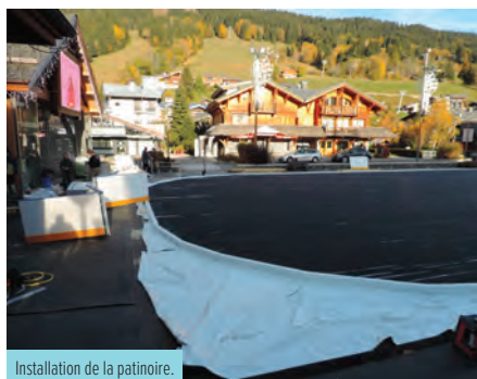
Installation de la patinoire.
