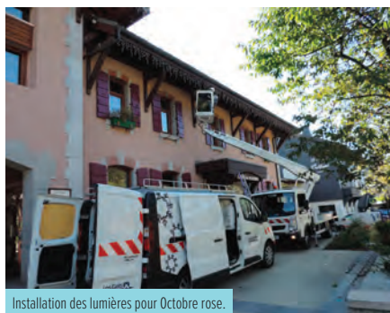
Installation des lumières pour Octobre rose.
