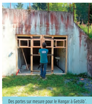
Des portes sur mesure pour le Hangar à Getslib'.
