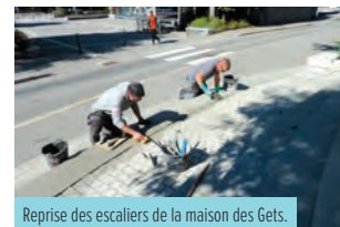
Reprise des escaliers de la maison des Gets.
