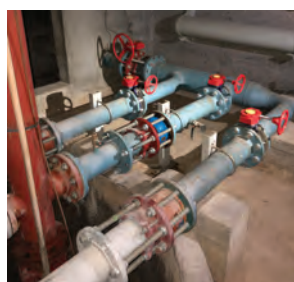
Pompes de forage dans le puit de BONNAVAZ. Capacité de 100 m 3 /h/pompe.
