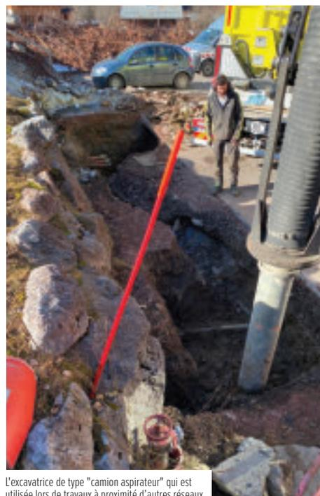
L'excavatrice de type "camion aspirateur" qui est utilisée lors de travaux à proximité d'autres réseaux.
