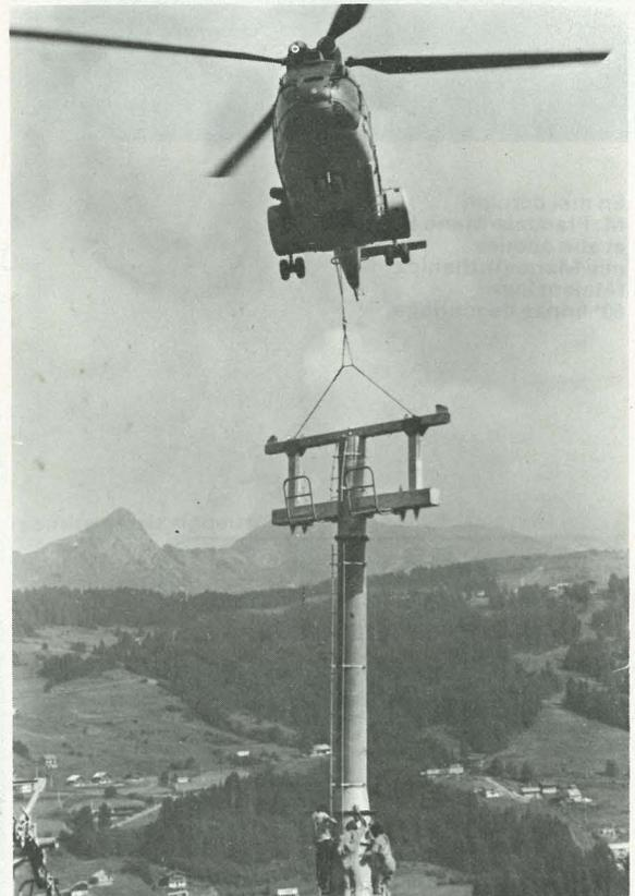
Pour poser les pylones, on a utilisé l'hélicoptère. ▲
