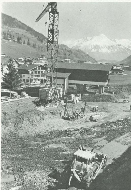
Un garage de 285 places a été construit autour de la gare inférieure de la télécabine des Chavannes. Vue de l'excavation. ▲
