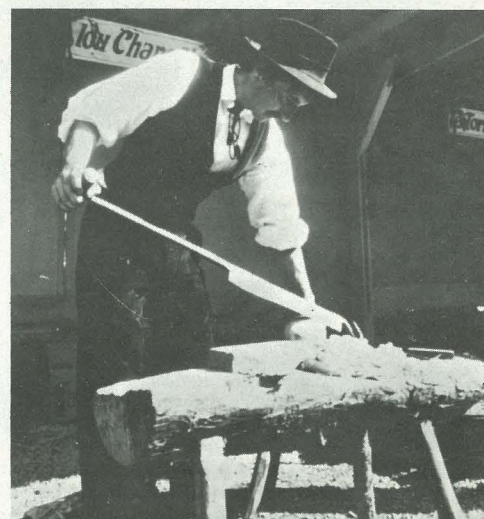
Fabrication d'une « poche ».
