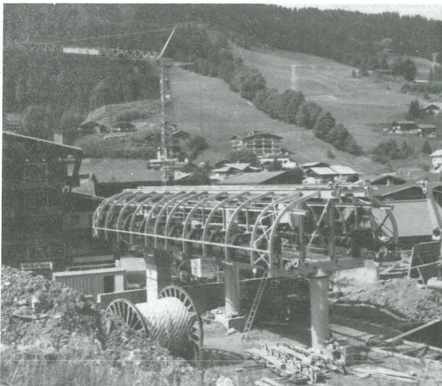
La charpente métallique de la gare inférieure, ressemble au squelette d'une immense baleine.
