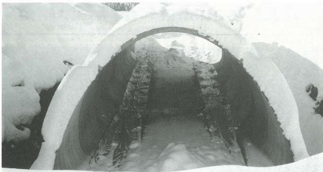
**PASSAGE SKIEURS DE LA PISTE VERTE : OUVRAGE RÉALISÉ EN ÉLÉMENTS DE BÉTON PRÉFABRIQUÉS D'UNE LONGUEUR TOTALE DE 25,50, 6 MÈTRES DE LARGEUR ET 4 MÈTRES DE HAUTEUR. 12 CAMIONS SEMI-REMORQUE ONT ÉTÉ NÉCESSAIRES AU TRANSPORT DE CES ÉLÉMENTS, MIS EN PLACE PAR UN CAMION-GRUE.**
