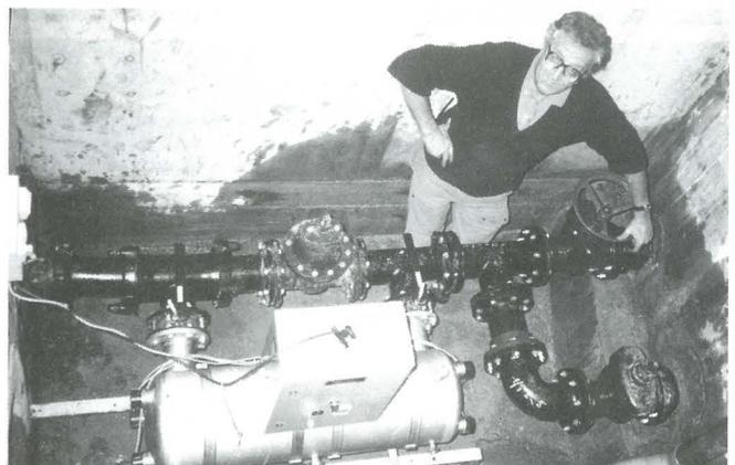
M. André COPPEL dans la chambre des vannes du réservoir, effectuant les derniers réglages du stérilisateur de traitement de l'eau par rayonnement U.V.
