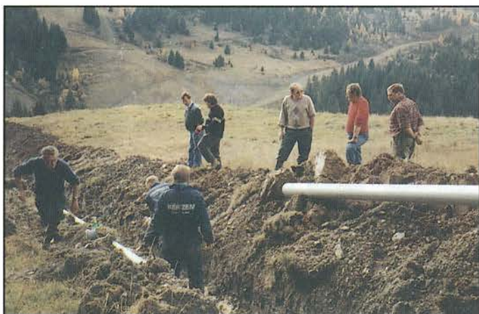
Pose de canalisations pour enneigement artificiel, Piste du Nauchet.
