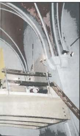
Remontage de l'orgue
