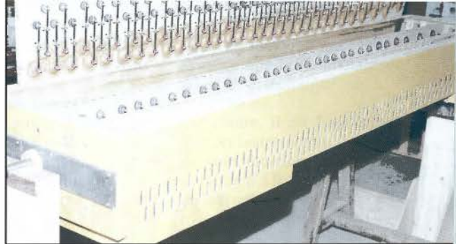
2280 boursettes et valves ont été refaites à neuf.
