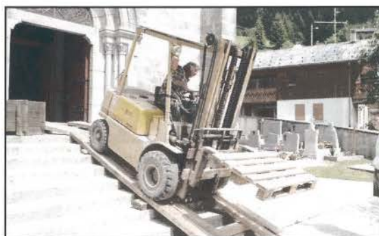
Un élévateur sera utilisé dans l'église pour monter les pièces de l'orgue sur la tribune
