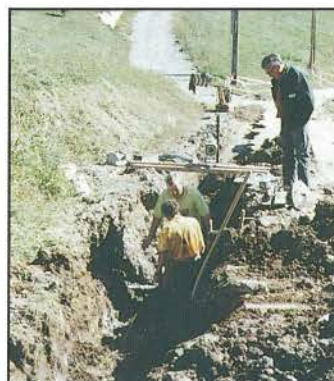
Assainissement sur la route des Cornuts d'en bas.
