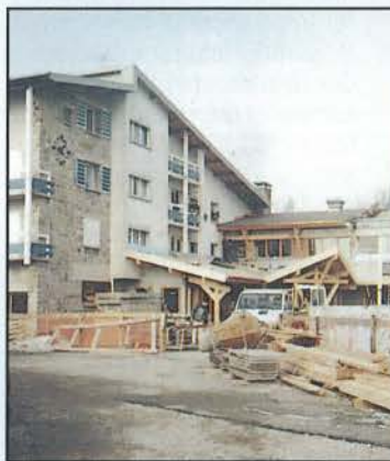
12 décembre 94. Les travaux à l'entrée du SELF du collège.
