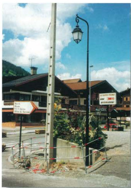
Un des anciens poteaux béton à retirer, et à côté le nouveau candélabre d'éclairage public
