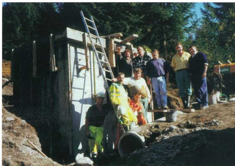
Réunion de chantier à la chambre de captage des Clares.
