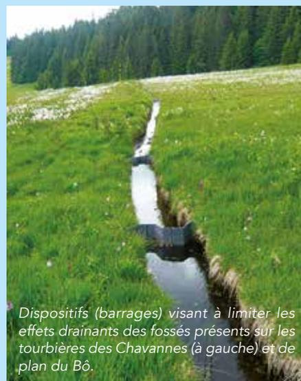
Dispositifs (barrages) visant à limiter les effets drainants des fossés présents sur les tourbières des Chavannes (à gauche) et de plan du Bô.
